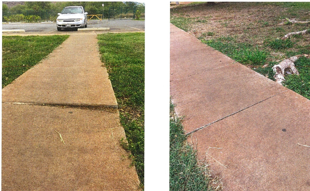
Photo 2.3. Uneven Pavement
